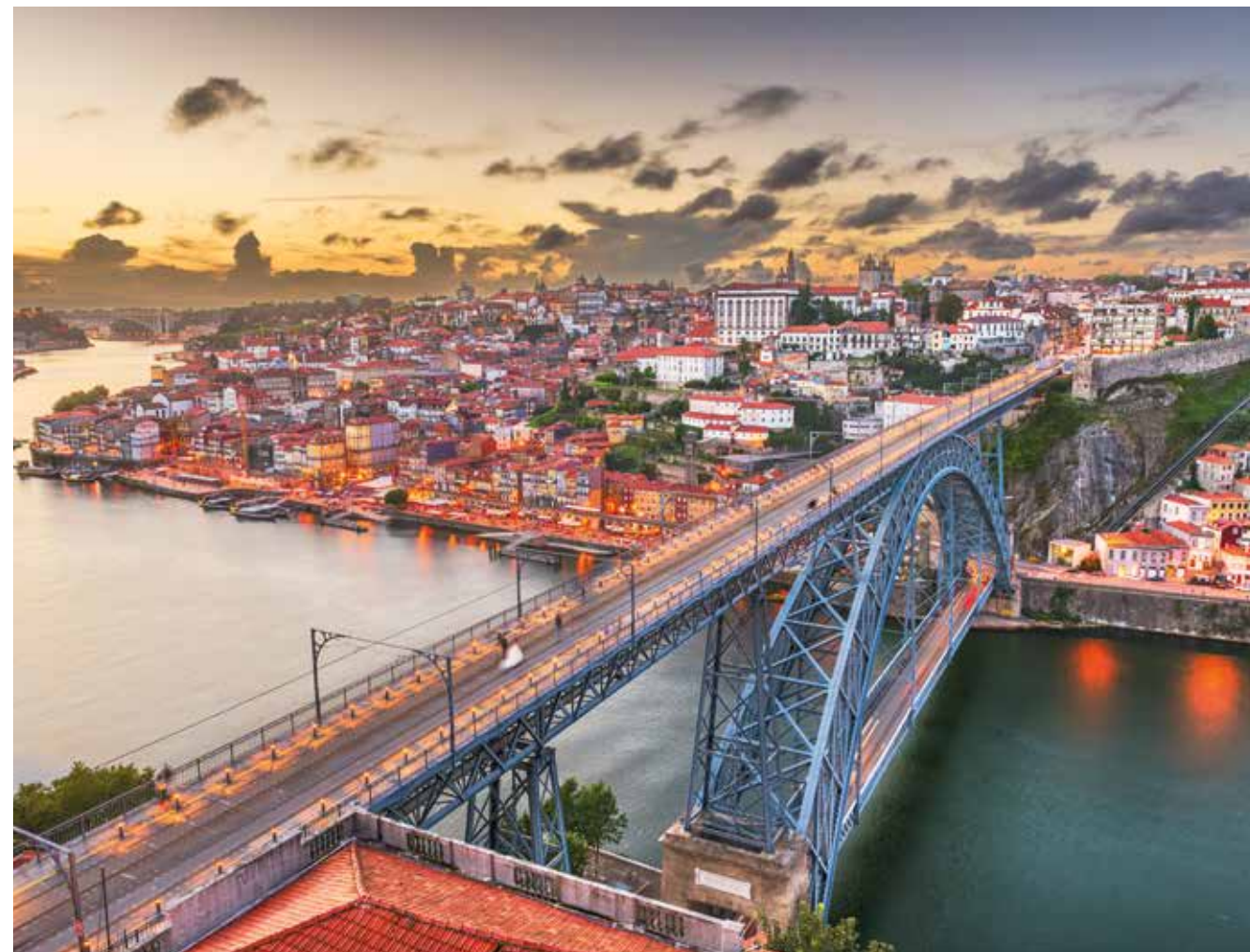
Ponte de Dom Luís (obra de Gustave Eiffel) - Porto
